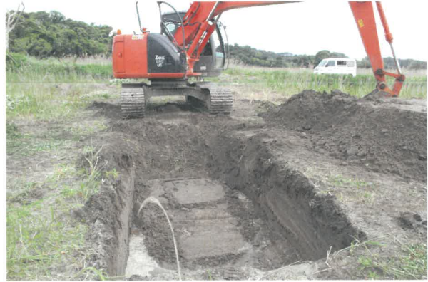
T26 トレンチ全景 (南から)
