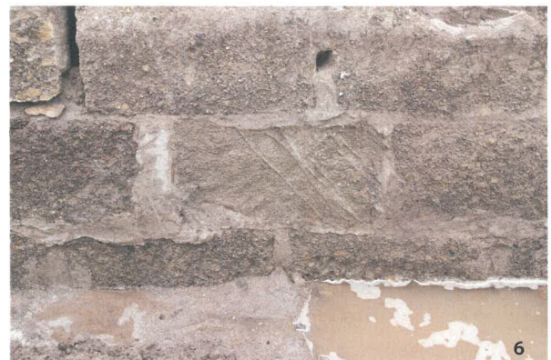
T3 トレンチ出土の第I期堤防表法の練石積 (布積) 拡大 (西から)
