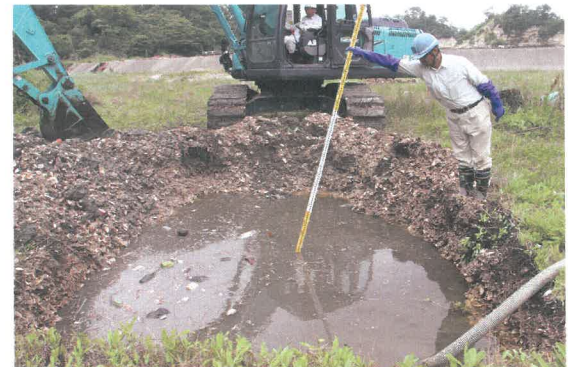
T 6 トレンチ全景(南から)
