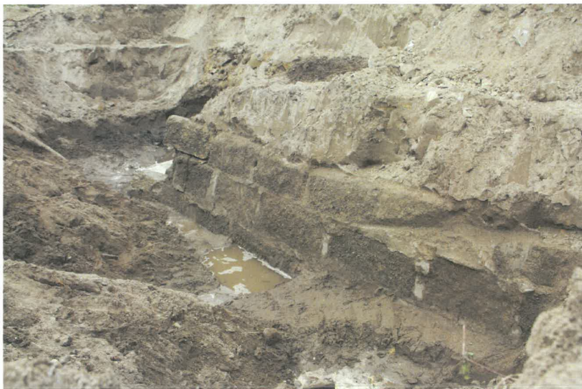
T3 トレンチ出土の第Ⅰ期堤防表法の 練石積（布積）（南西から）
