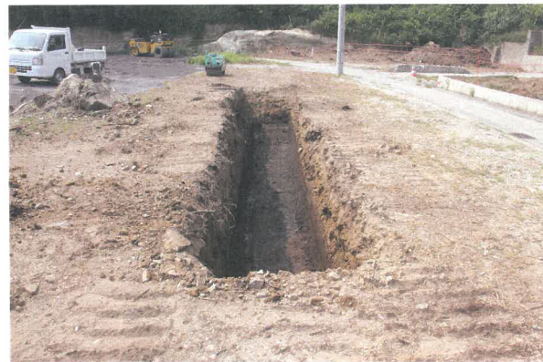
T 5トレンチ全景（東から）
