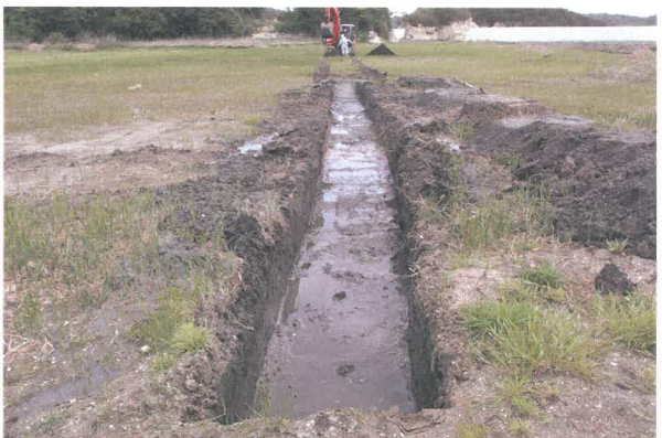
T7トレンチ全景 (西から)
