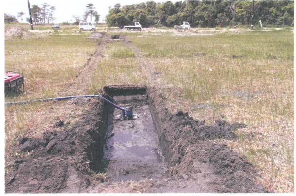
T8トレンチ全景（東から）
