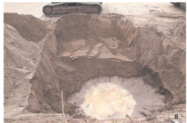
T2 トレンチ (東から)
