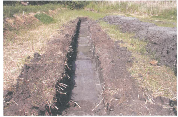
T16トレンチ全景（西から）
