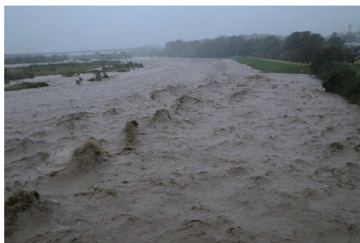
令和元年 台風 19 号最接近時の信玄堤
