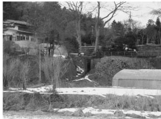
写真2 花立山からの張り出し部と水路
