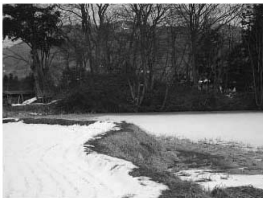
写真3 東堤防の築山状マウンド（西から撮影）
