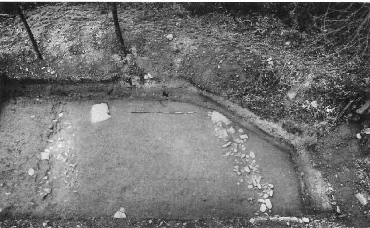
3. 礎石雨落溝・ 地覆 (金堂北 東部) 廻廊
