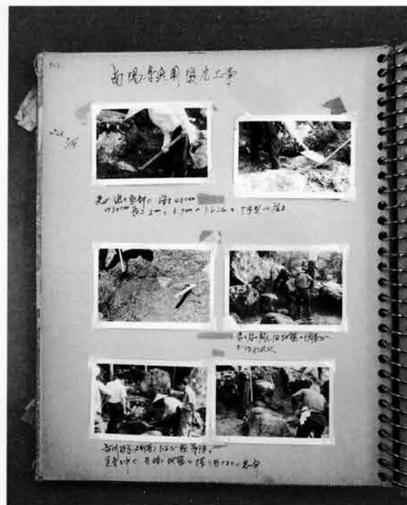
挿図34 写真集 (「南陽寺庭園復元工事」のページ)
