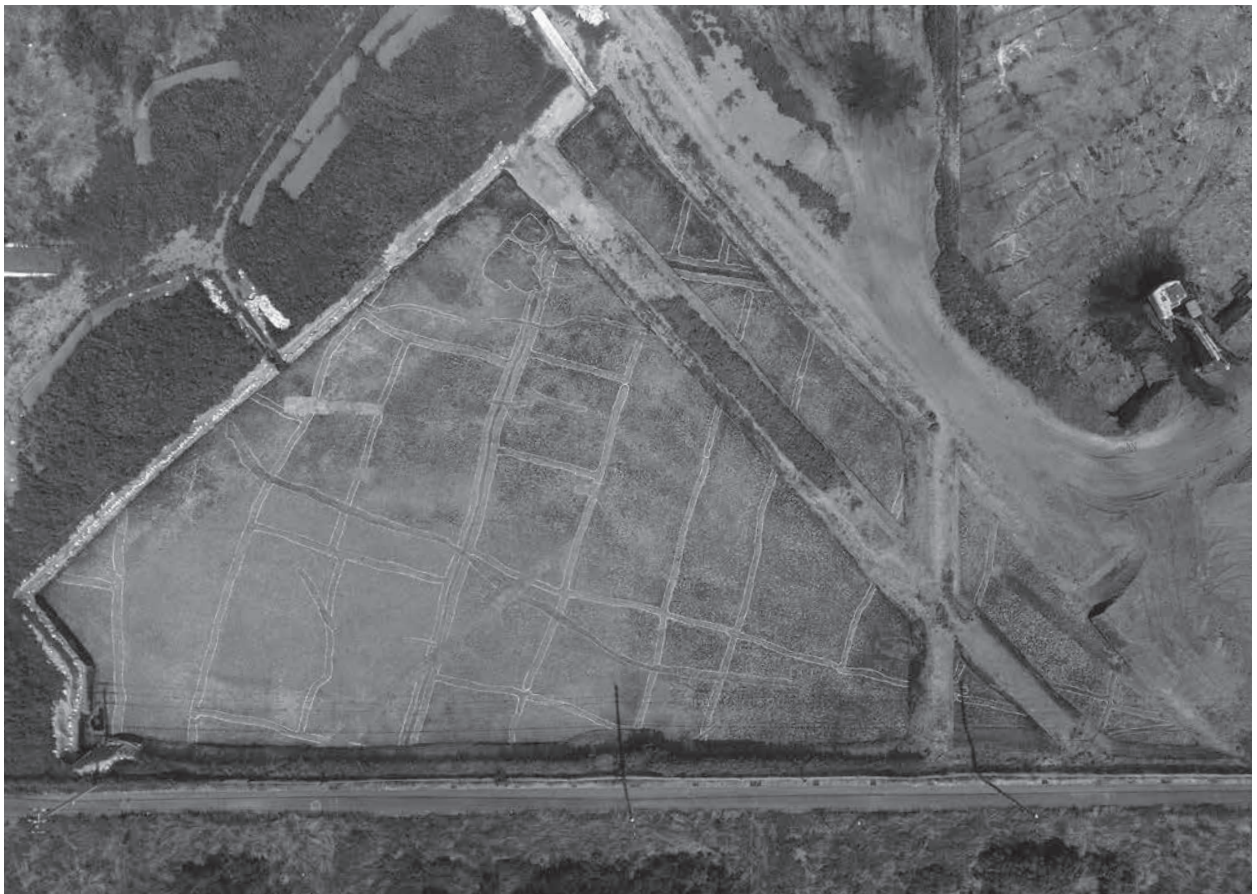
7～10区第1面全景（上が東北東）
