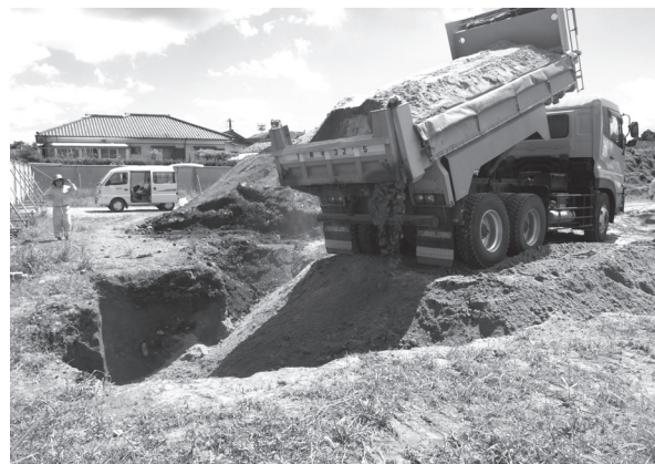
図版2. シラスを用いた埋戻し
