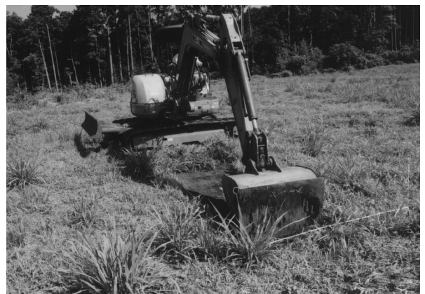
図版 12. 重機使用状況
