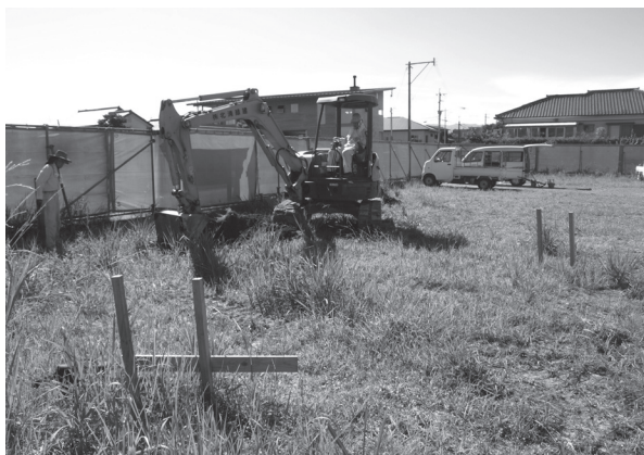
図版1. 重機使用状況(表土掘削)
