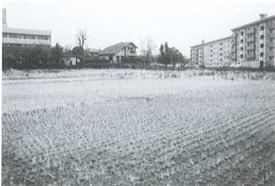
図版5. 全景(南西から)
