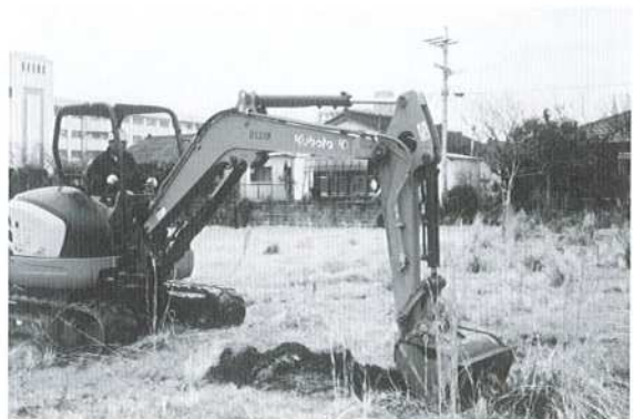
図版6. 重機使用状況
