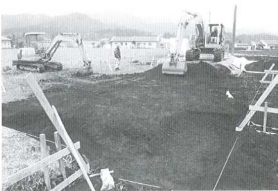
図版 1. 工事立会状況
