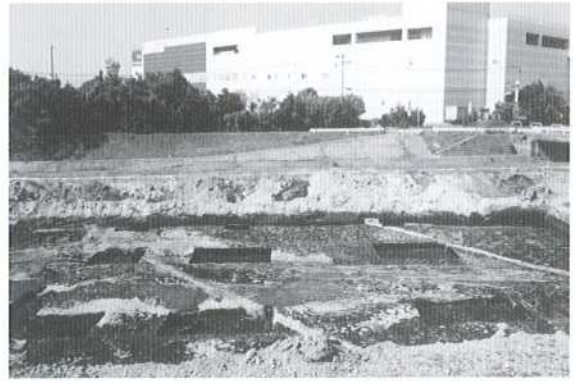
図版4. 工事立会：1区北側(東から)
