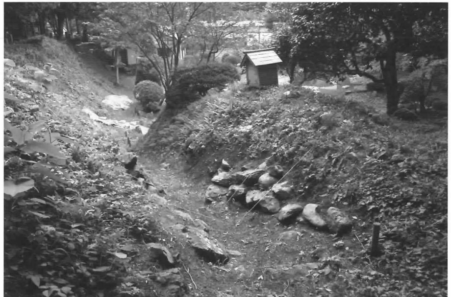
2. TP-14 (1) 庭園東側の土塁に沿って通路がある。築山と土塁の間には、石による土留めがなされる。
