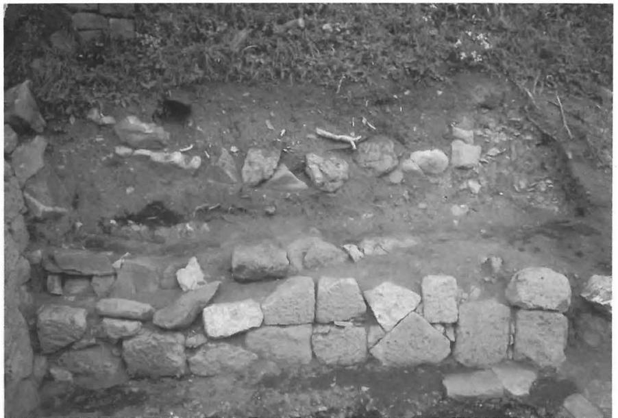
3. ▷埋門を通る土居天端の断面を見ていることになる。石積みの際、合場などを加工する時に排出される碎片は、裏込めに層を成して堆積することを過去の調査で確認している。したがってこの最上位の碎片層は、天端調整時に堆積したと考えられる。なお、この土居上の土塀は、法面を登り、多門櫓の南西隅に取り付くことが「松前神社所蔵線図」（資料2）から判明する。
