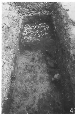
3 2 よりもう一段掘り下げると、基壇地業下層部の裾まわりに砂利を敷いている。4 も同様。
