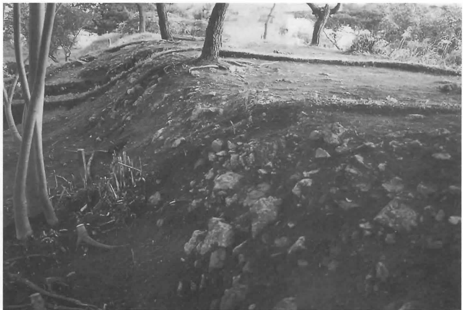
2 土壘内部の盛り土は外堀の掘り上 げ土が使用されている。表面に見 える礫は、外堀を掘った際の地山 岩盤の砕け石である。
