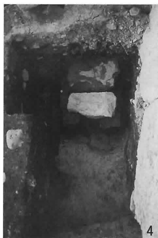
3. 4 石段下の暗渠。石段および隅槽の 乗る土居内側の石垣根掘りに透る 雨水を砂利を介して受ける。
