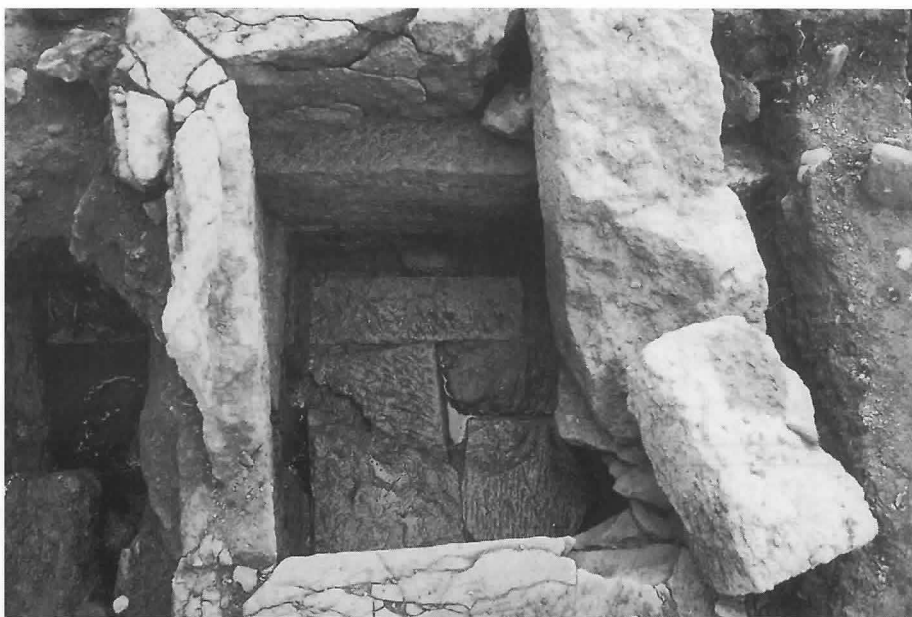
1 左側に排水し、他の三面から水を うける。内法はほぼ2尺5寸四方 で、深さは最大で3尺4寸。
