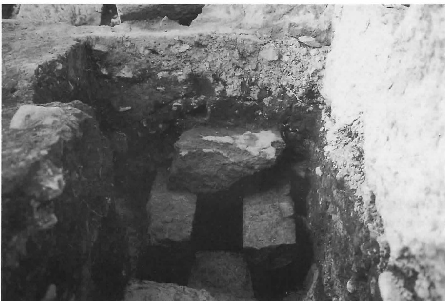
3. 4 石段下の暗渠。石段および隅槽の 乗る土居内側の石垣根掘りに透る 雨水を砂利を介して受ける。
