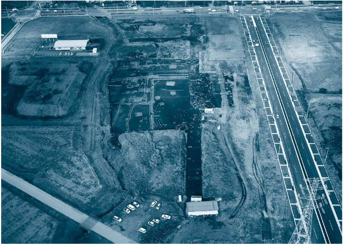
17区 全景 (南上空から)
