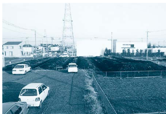
32区 トレンチ (西から)
