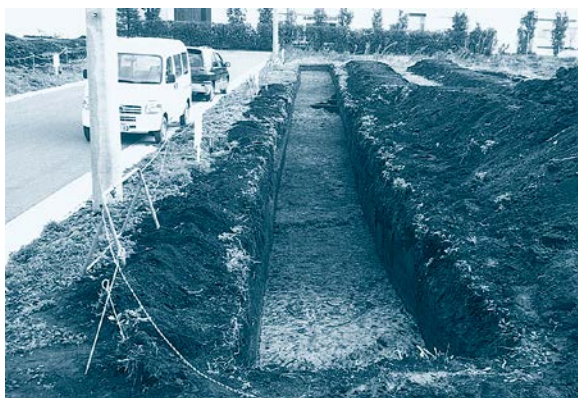
33区SD-1・2・3北側トレンチ 完掘 (西から)
