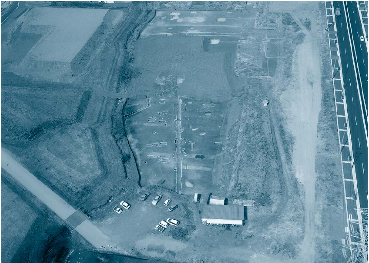
20区 全景 (南上空から)
