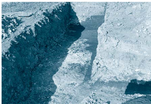
31区旧河川砂利確認状況 (南東から)
