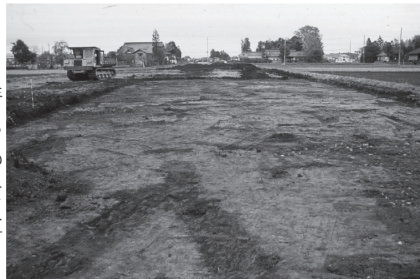
土俵除去後の様子(Ⅱ区)
