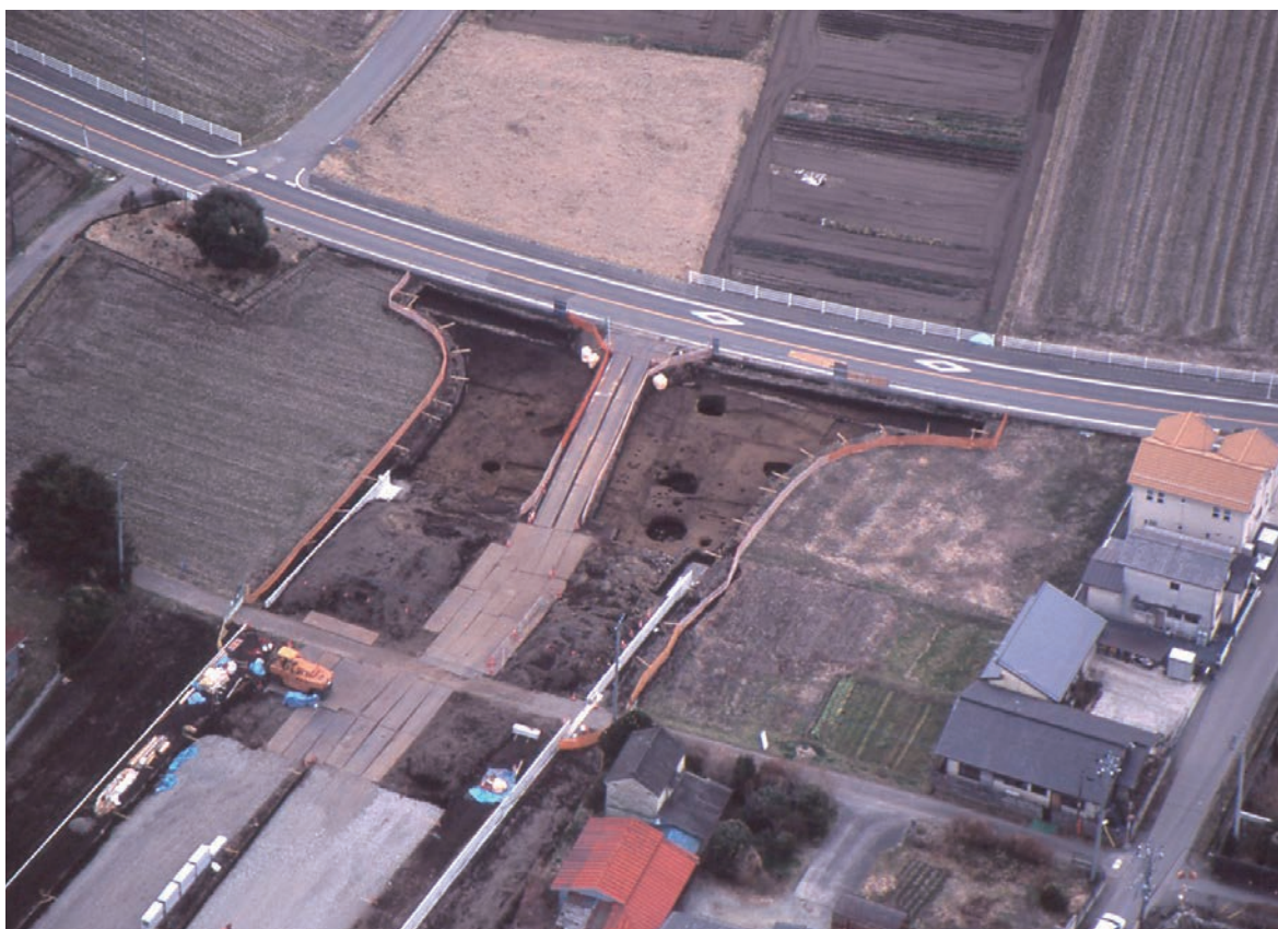
I-2区・I-3区全景(北西上空から)
