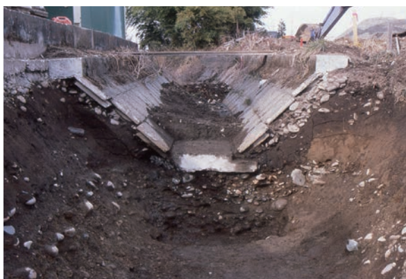
Ⅲ-3区 SD-001A-A' セクション (南から)
