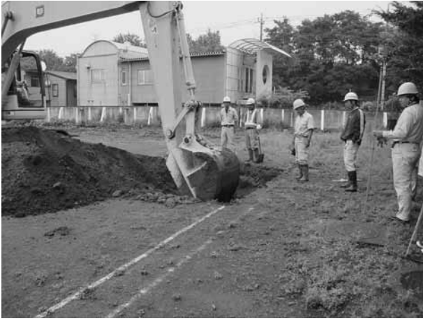
1. 表土掘削開始 (南から)
