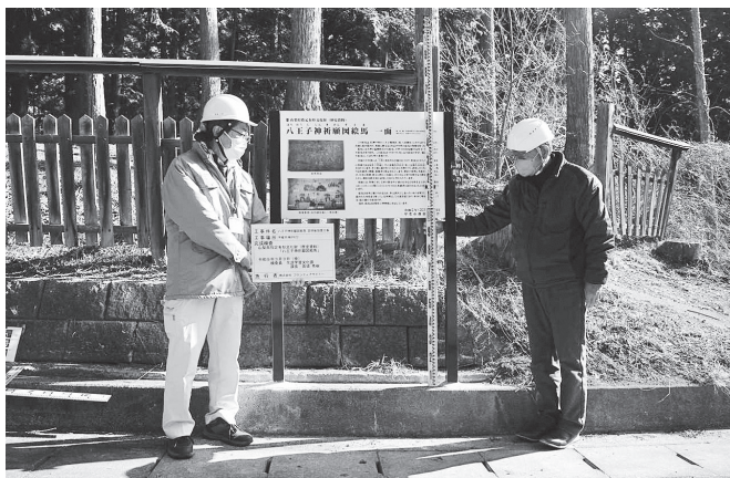
八王子神祈願図絵馬 説明板工事検査
