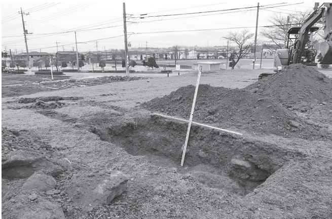
TR-2 掘削状況（北東から）
