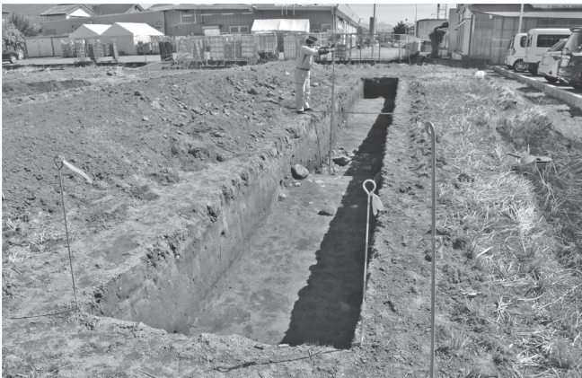
TR-4 掘削状況 (西から)
