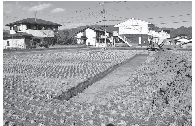
掘削状況（南西から）
