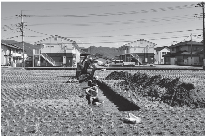
掘削風景（西から）
