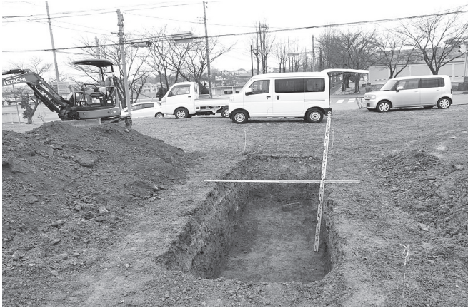
TR-1 掘削状況（東から）
