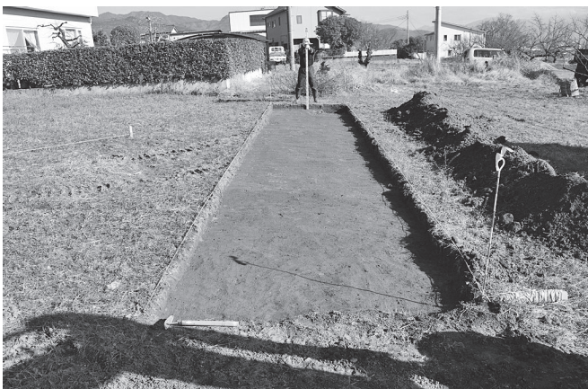
TR-2 掘削状況（西から）
