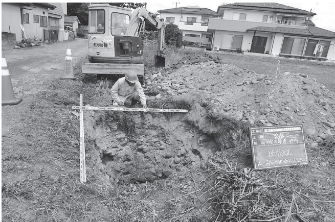
掘削状況（東から）
