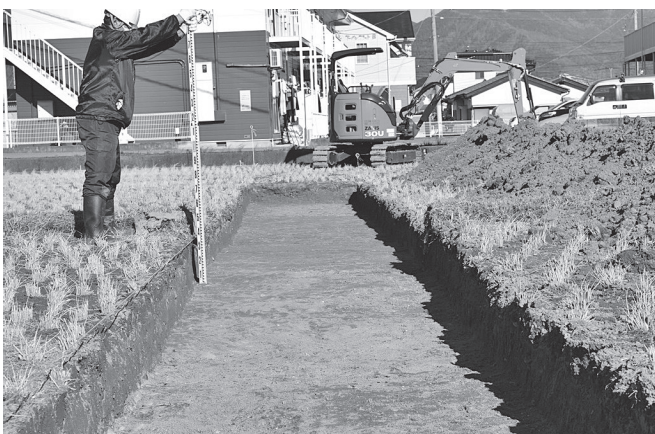
掘削状況（西から）
