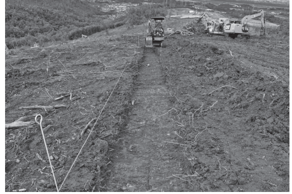
トレンチ掘削風景（北から）
