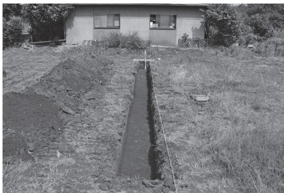
トレンチ掘削状況（南から）
