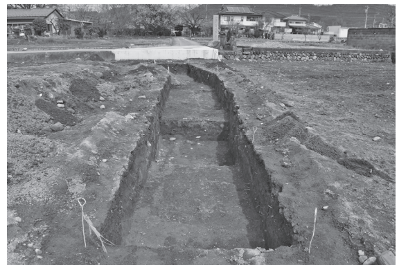
トレンチ掘削状況（南から）
