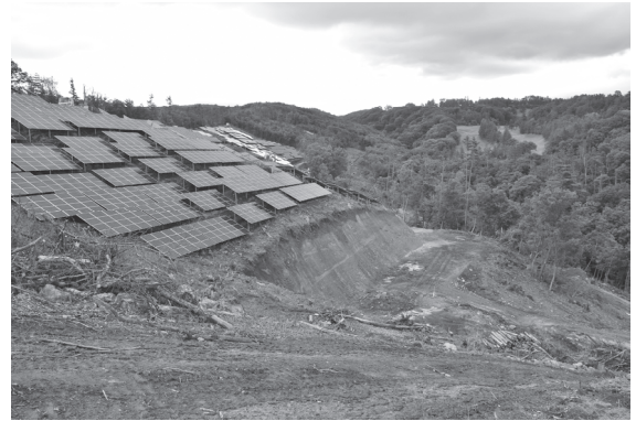
太陽光パネル設置状況（南から）
