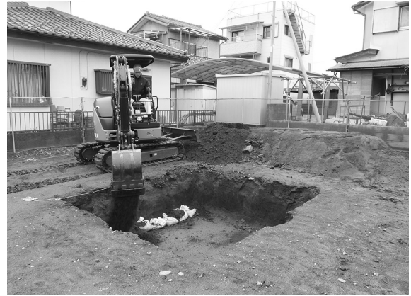
埋め戻し状況（南東から）
