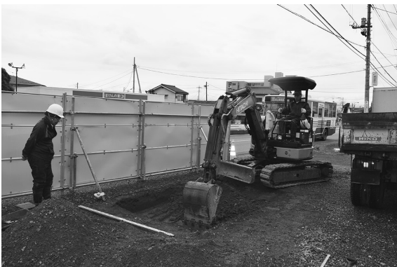
試掘調査 表土剥ぎ
