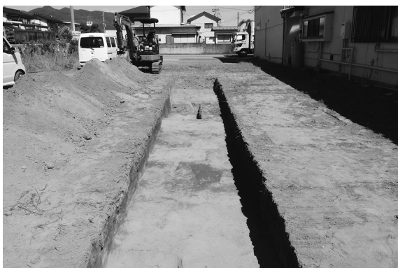
完掘状況（西から）
