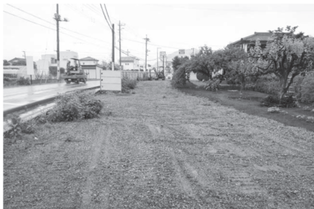
県道東側 掘削前状況（南から）
