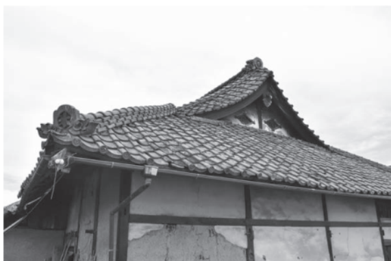
中村家住宅（北西から）
