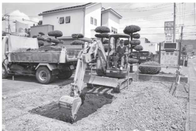
県道西側 掘削状況（南から）
