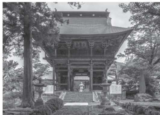
天澤寺山門（修理後）
