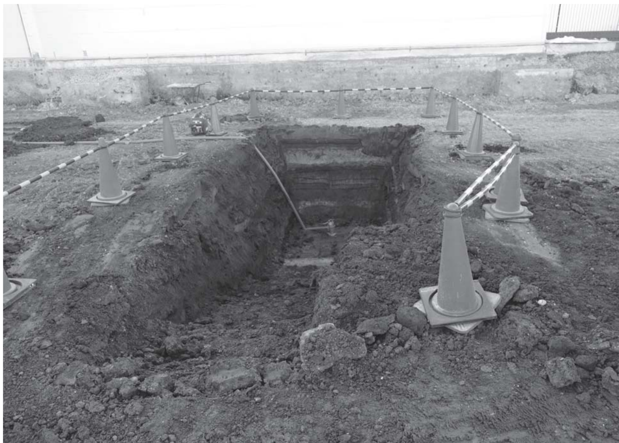
3工区トレンチ (北から)
