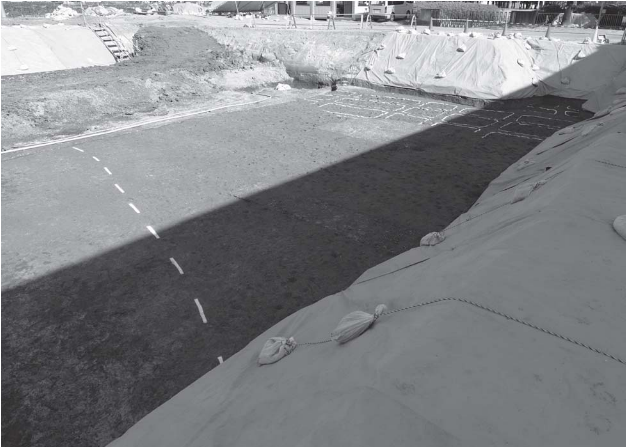
Hr-FP洪水層下水田南側全景（南西から）
