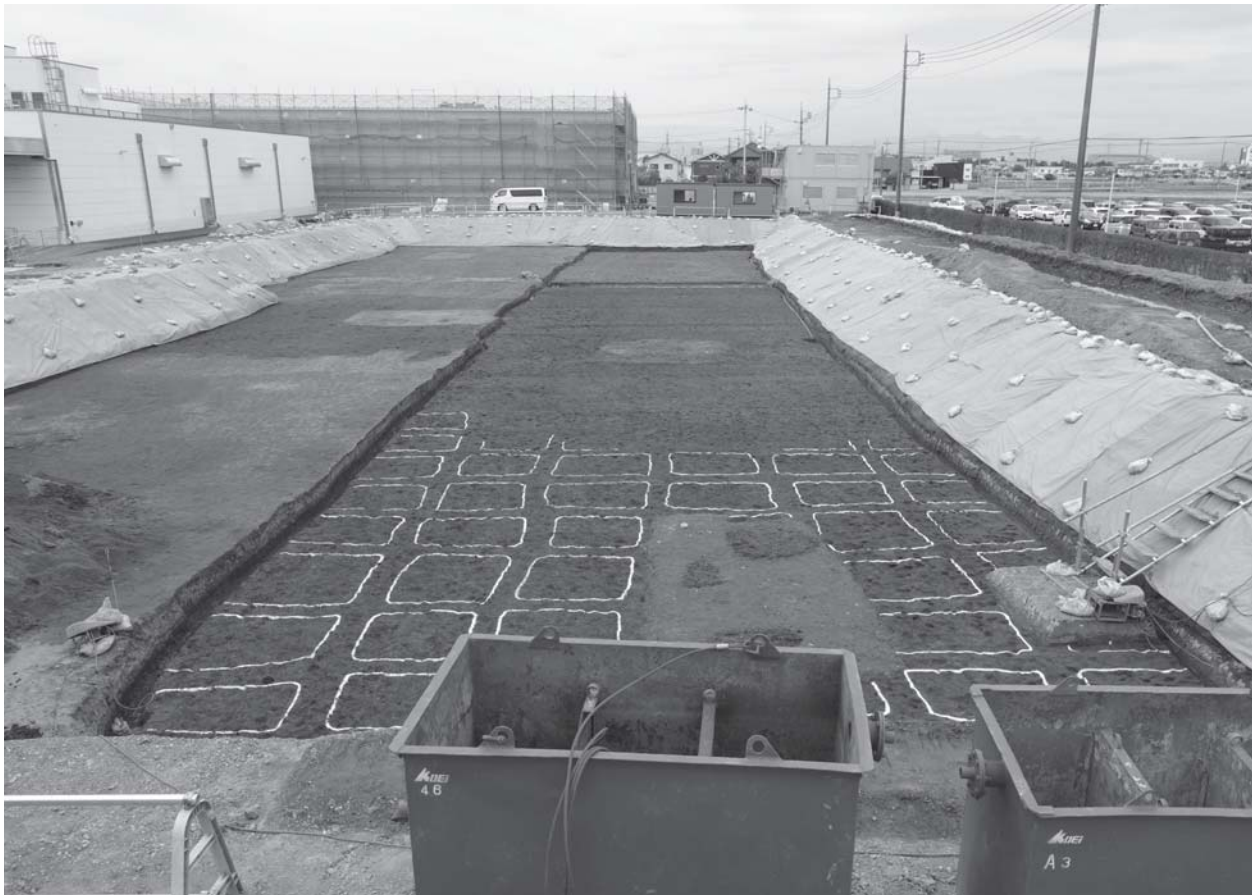
Hr-FA 洪水層下水田北側全景（東から）
