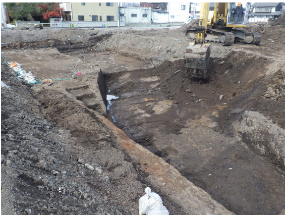
作業風景 (表土掘削)
