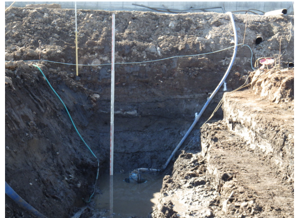
堀 (SD-1) 深掘りトレンチ Bsec 北から
