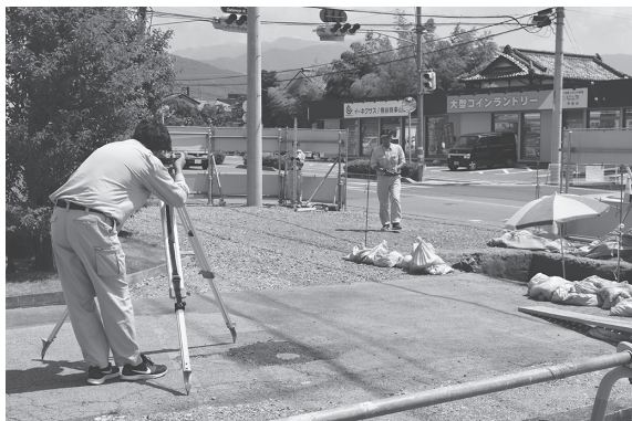
写真3 測量委託 実施状況（BM設定）
