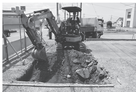
写真2 表土剥ぎ 掘削風景（南区）
