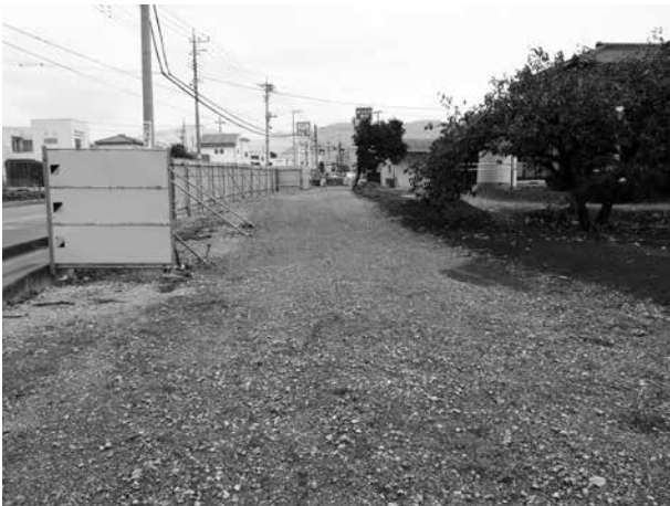
1区 調査前風景（南から）
