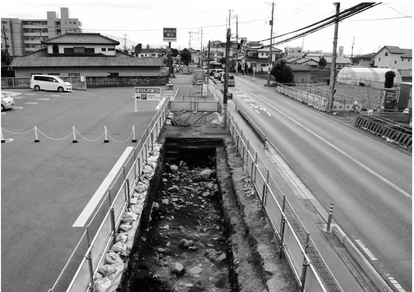
2区C 調査区周辺の様子（北から）
