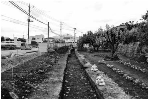
写真1 県道東側 試掘状況
