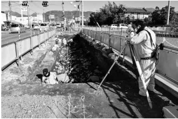
写真3 測量委託 実施状況（県道東側）
