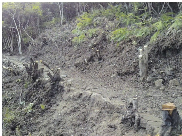
147 路肩石積 立面 (南東から)
