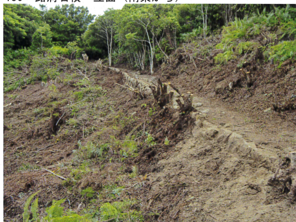
152 路肩石積 立面 (南東から)
