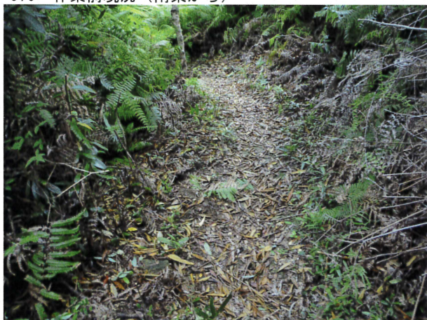
072 作業前現況 (北東から)
