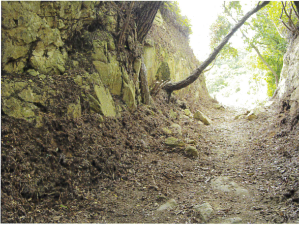
107 掘割 全景 (南東から)
