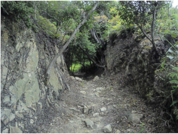
099 掘割 清掃前 全景（北から）
