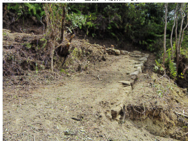
138 古道（路肩石積） 全景（南西から）
