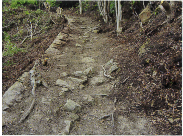
124 古道（路肩石積） 全景（南東から）
