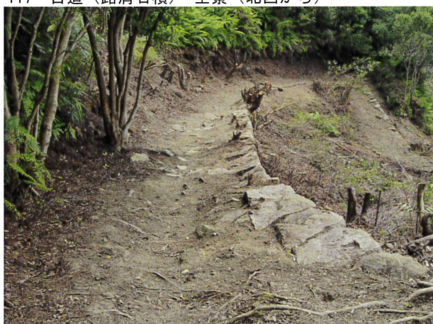
119 古道（路肩石積） 全景（北西から）
