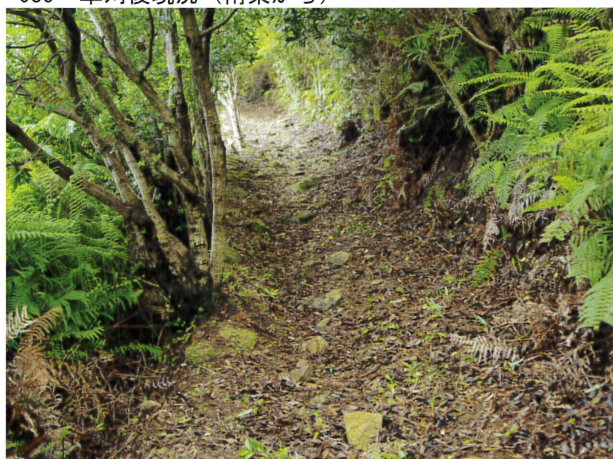
087 草刈後現況 (南東から)
