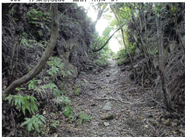
061 作業前現況 掘割 (南から)
