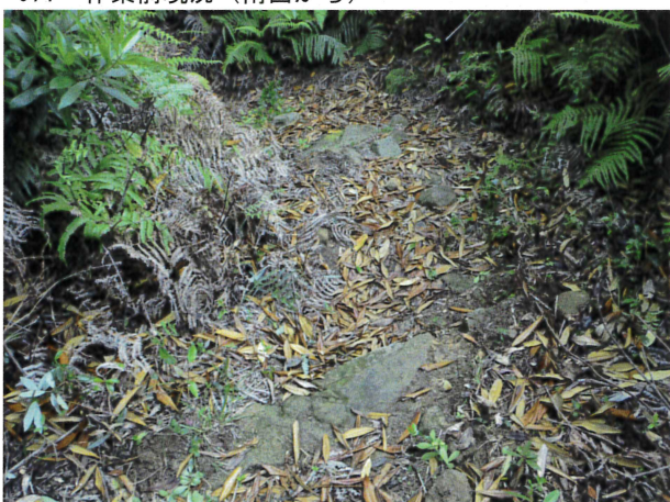
073 作業前現況 (北東から)
