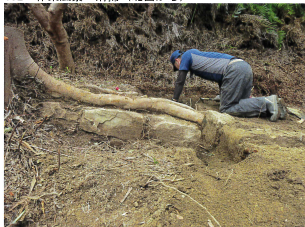
054 作業風景 排水溝調査（南西から）
