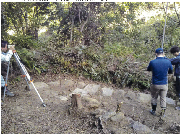
055 作業風景 レベル測量（北西から）
