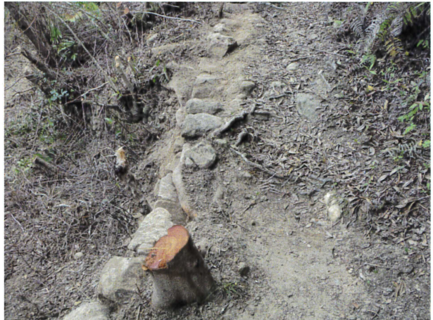
130 古道（路肩石積） 全景（南東から）
