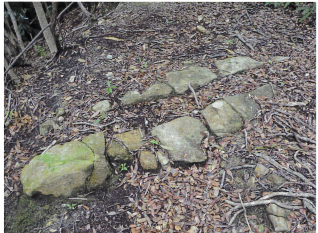
200 石組排水溝 (馬転坂西側 大串峠) (西から)
