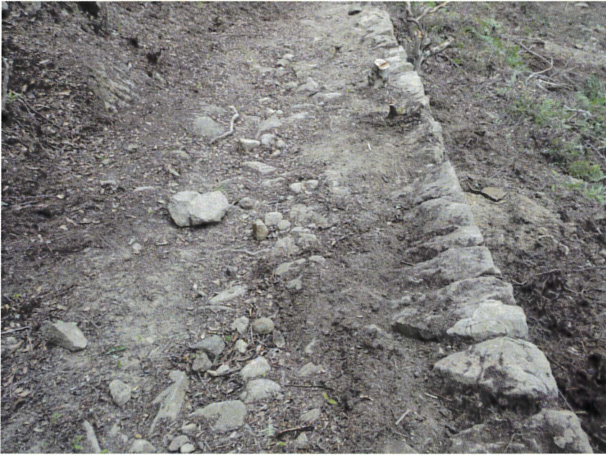
123 古道（路肩石積） 全景（北西から）
