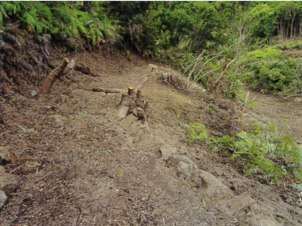
127 古道（路肩石積） 全景（北西から）
