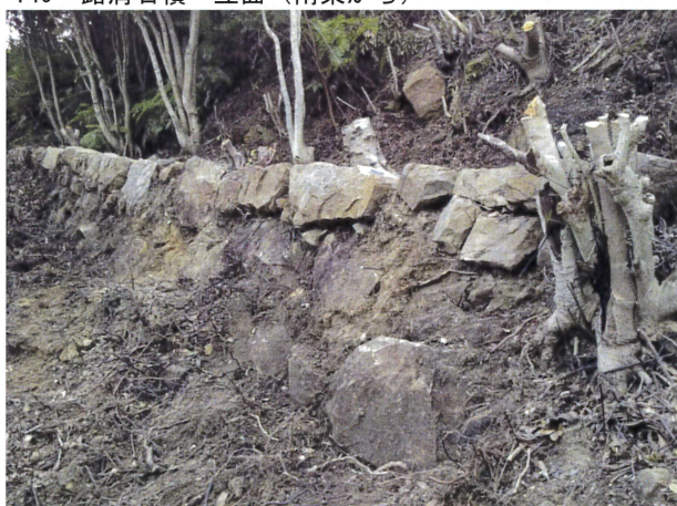
151 路肩石積 立面 (南東から)
