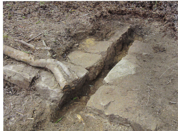
192 石組排水溝 (南から)
