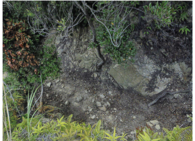
104 掘割 全景（上から）
