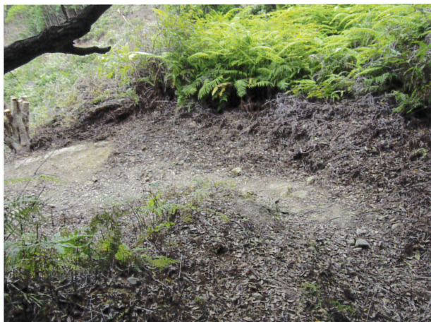
115 古道（路肩石積） 全景（北から）
