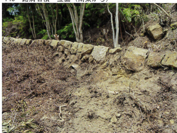
150 路肩石積 立面 (南東から)
