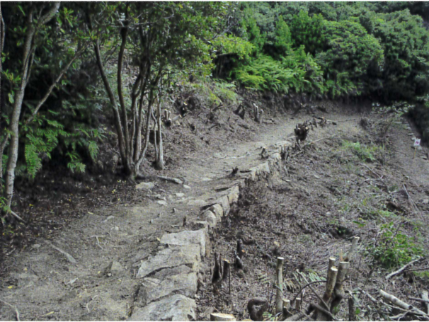
125 古道（路肩石積） 全景（北西から）
