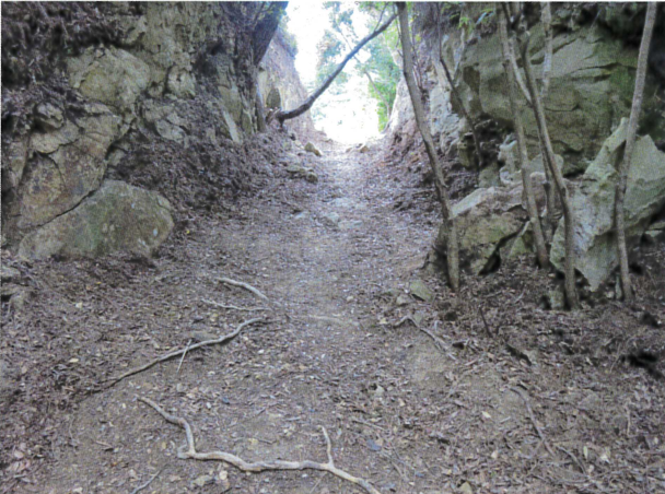
109 掘割 全景 (南から)
