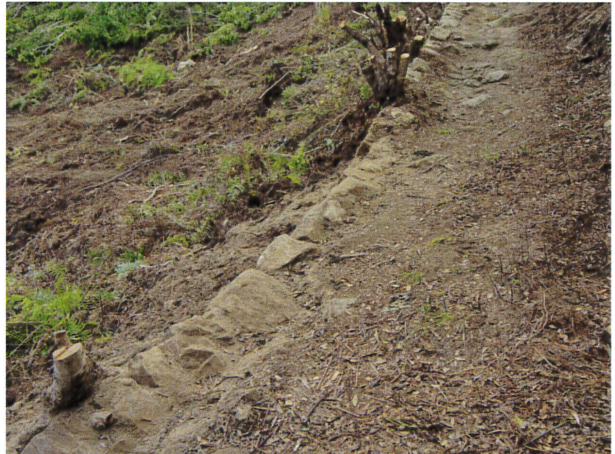
128 古道（路肩石積） 全景（南東から）
