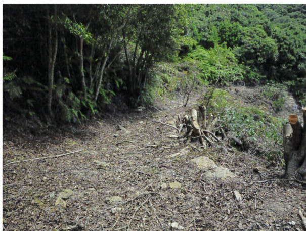
092 清掃前現況 (北西から)
