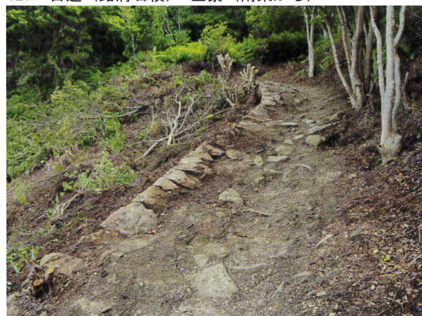
122 古道（路肩石積） 全景（南東から）
