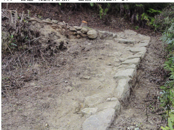
137 古道（路肩石積） 全景（南西から）
