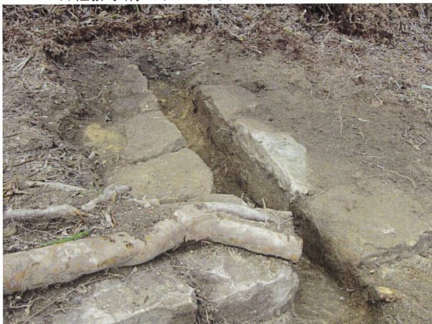
191 石組排水溝 (西から)
