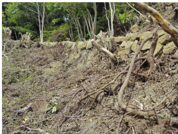
148 路肩石積 立面 (南東から)
