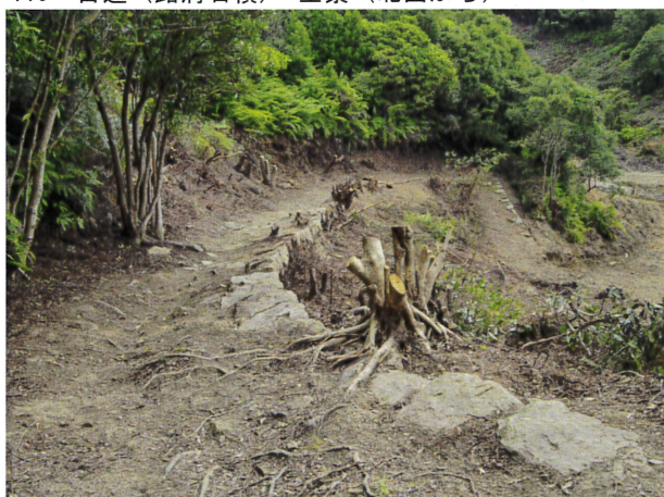
121 古道（路肩石積） 全景（北西から）
