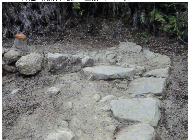
134 古道（路肩石積） 全景（南西から）
