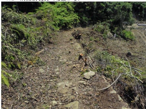
094 清掃前現況 (北西から)
