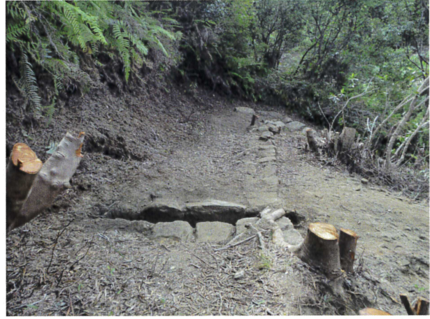
188 石組排水溝 (北西から)
