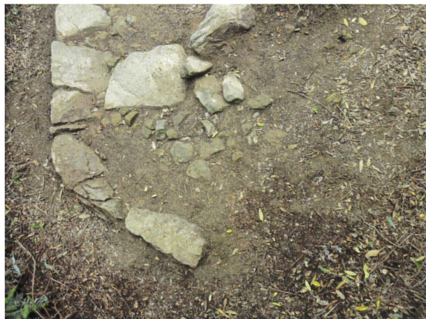
132 古道（路肩石積） 全景（上から）
