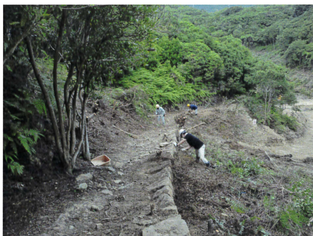
051 作業風景 清掃（北西から）
