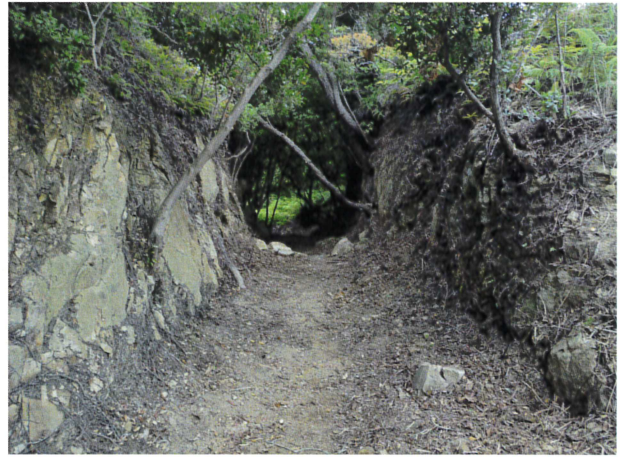
100 掘割 全景（北から）
