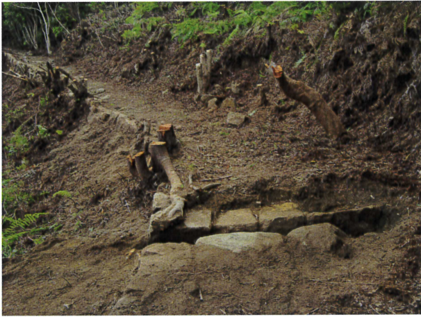
187 石組排水溝 (南東から)
