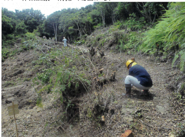
053 作業風景 清掃（南東から）
