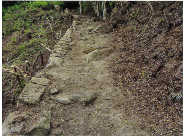
126 古道（路肩石積） 全景（南東から）
