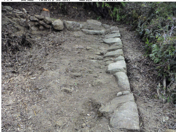
135 古道（路肩石積） 全景（南西から）
