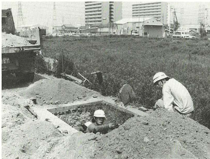
第1図 掘削作業風景
