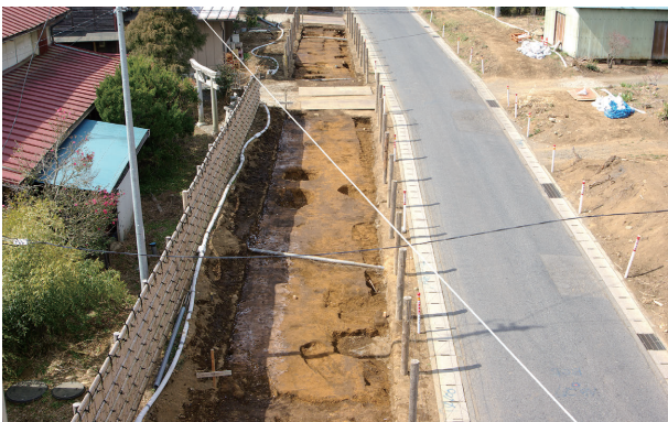
2 B・C区全景（東から）
