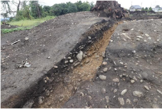
D-D' トレンチ西側墳丘盛土 (南西より)
