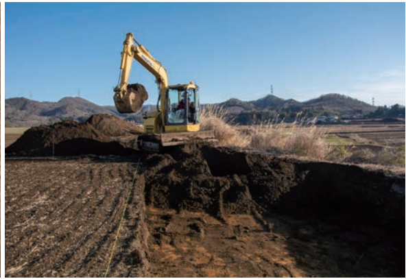
F区 表土除去作業 (北西から)
