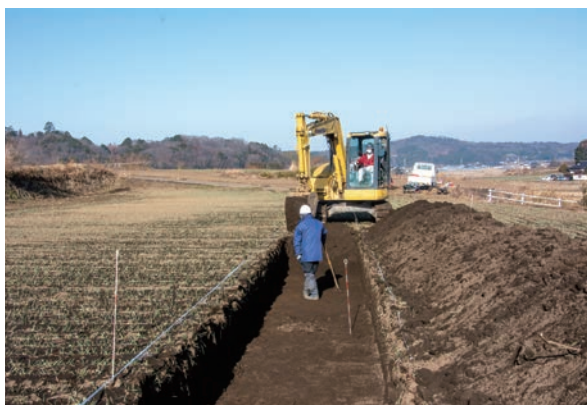
J-3区 トレンチ掘削（南東から）
