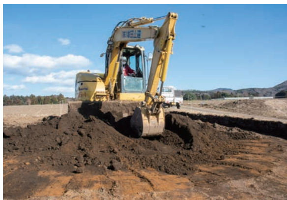
G区 重機表土除去 (西から)
