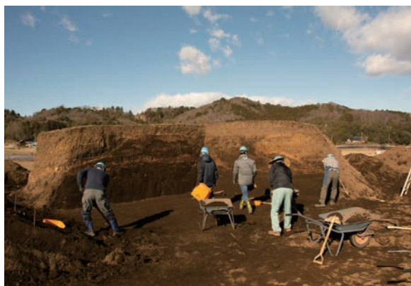
作業風景（南東から）
