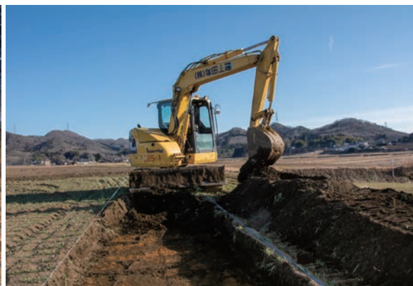
M区 表土除去作業 (北西から)
