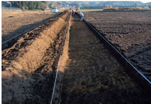
I-2区 トレンチ作業風景 (北西から)
