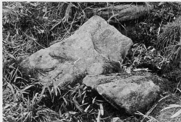
盗掘による天井石の崩落状況
