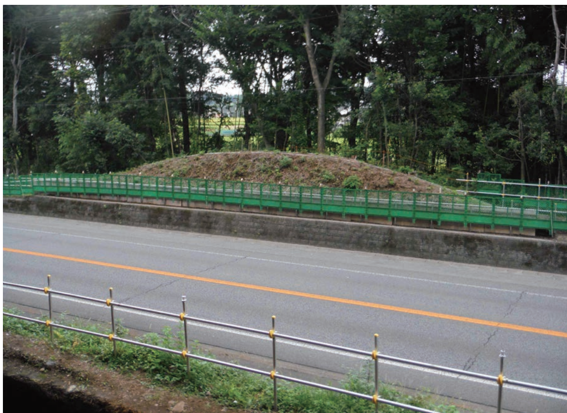
SZ-01 調査前状況（西から）
