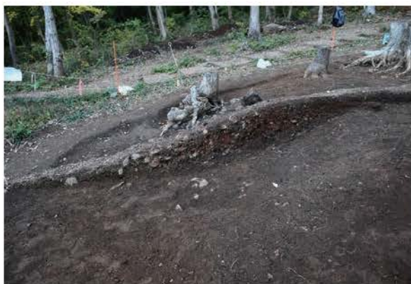
S-1 前庭部南側土層 (C-C') (東から)
