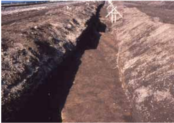
7区南全景(南から)
