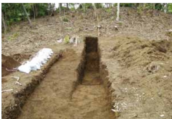
3 トレンチ完掘状況（北から）
