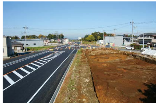
開通間近の主要地方道小山環状線間中工区と3次調査B区（東から）
