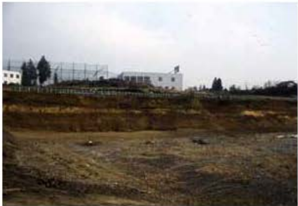
西側斜面確認状況
