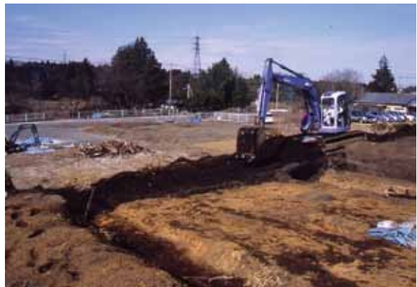
重機作業状況
