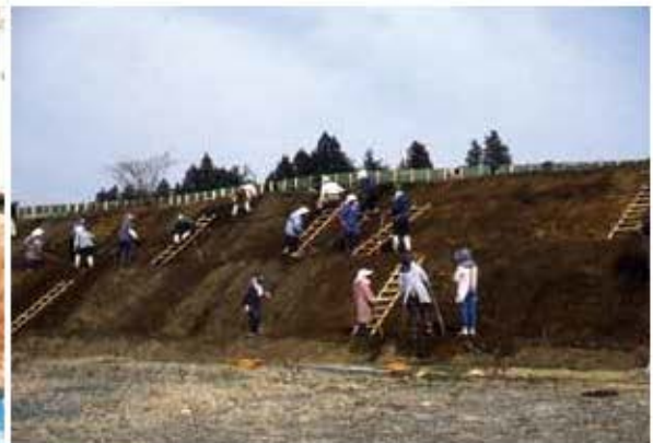
西側斜面作業風景
