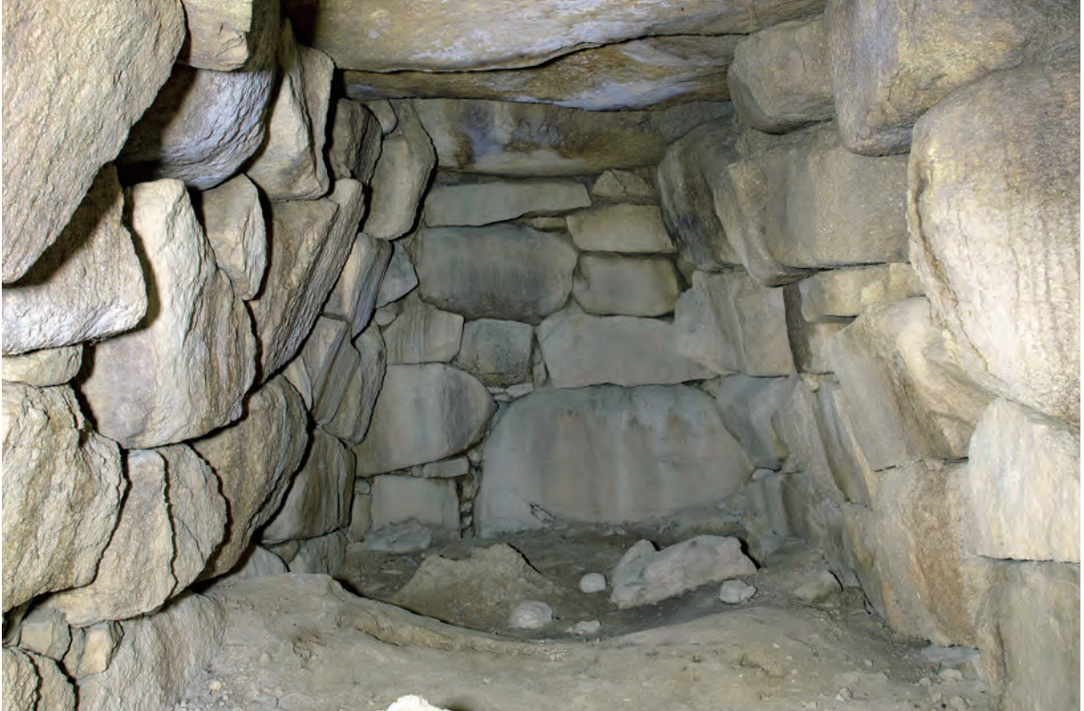
1 稲荷山C4号墳奥壁（東から）
