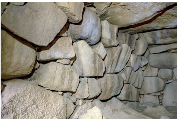
4 稲荷山C4号墳左側壁（東から）
