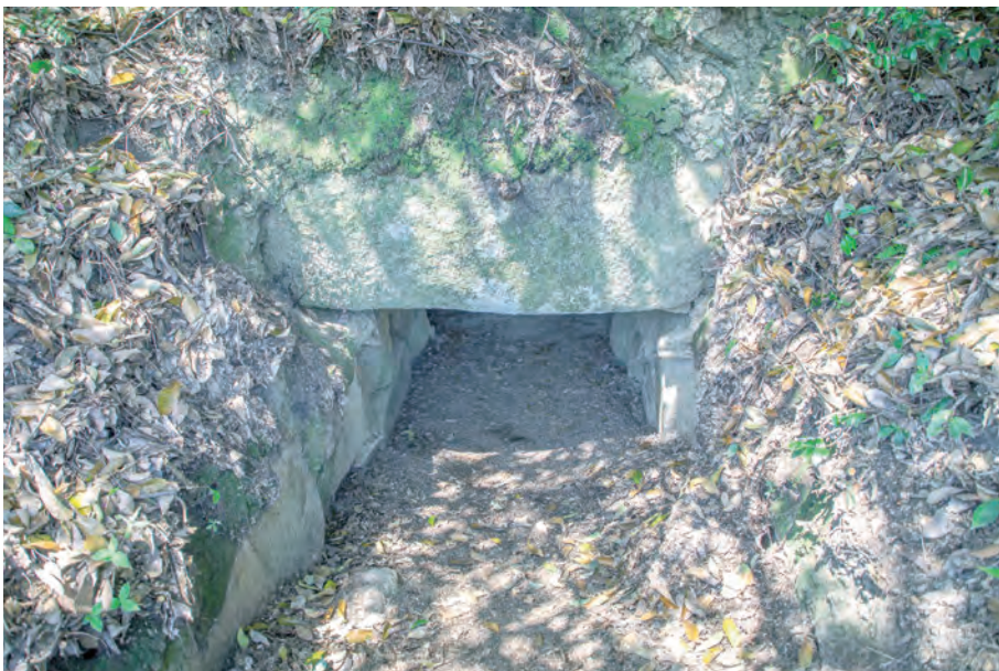
3 鳥取上高塚古墳 石室入口（南西から）
