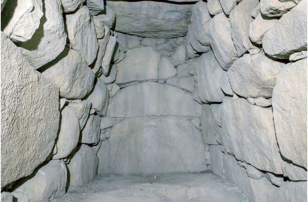
1 緑山8号墳奥壁（南西から）
