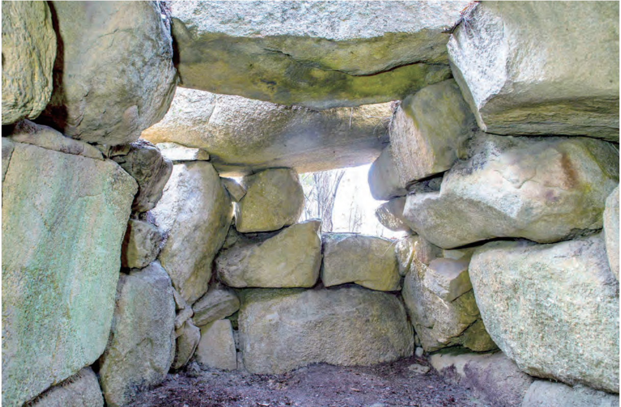
1 稲荷山C 10号墳奥壁（東から）
