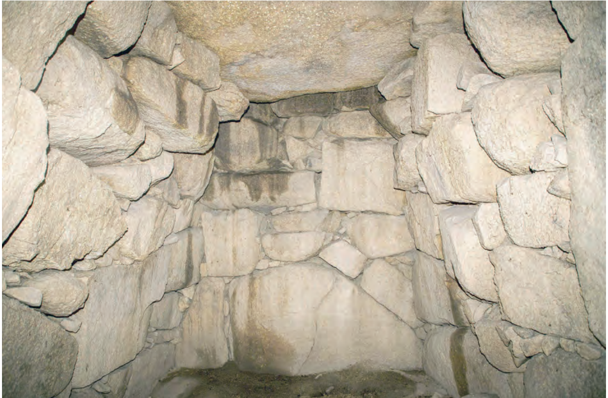
1 緑山7号墳奥壁（南西から）
