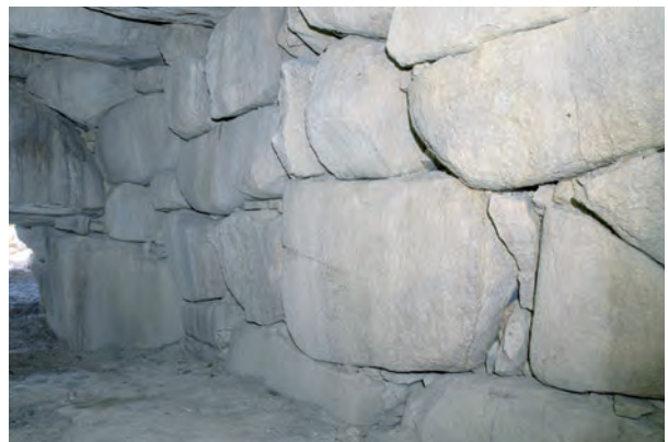
3 緑山8号墳左側壁（東から）
