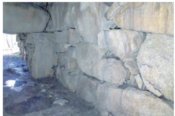
3 稲荷山C 36号墳左側壁（北から）
