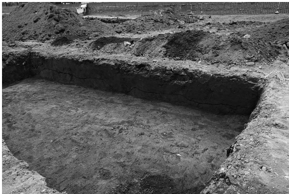
道地遺跡 | 地点セクション
