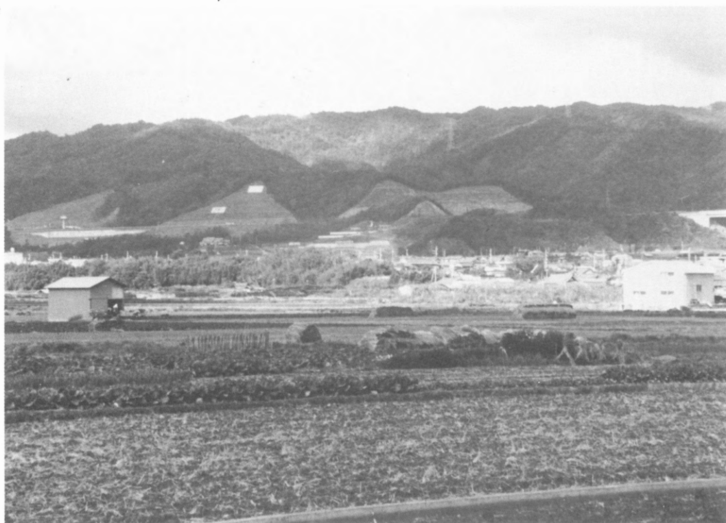
1. 遠景(南より・紀ノ川の堤防から)
