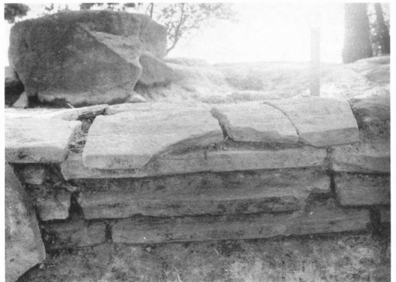
3 同上 階段瓦積細部
