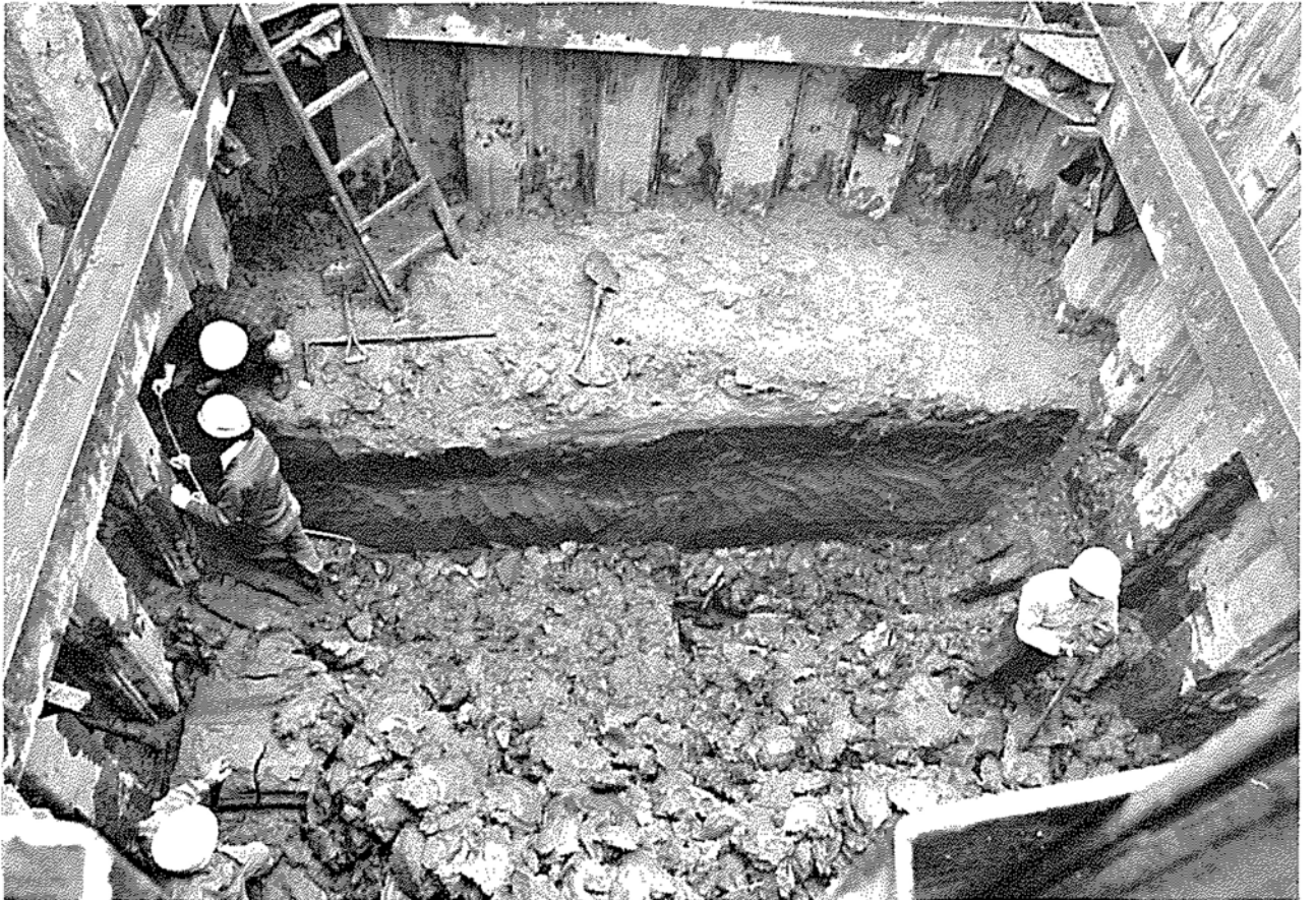
最終掘削後の断面
