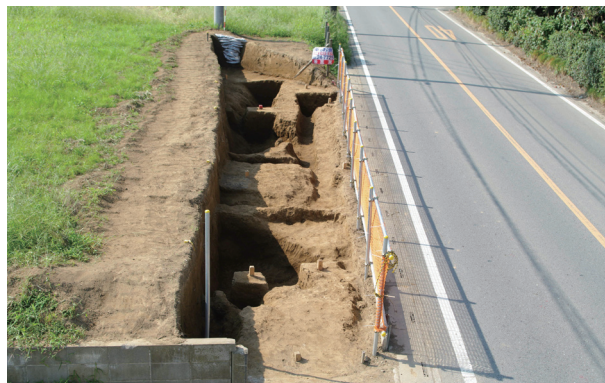
5 C区全景 (北から)
