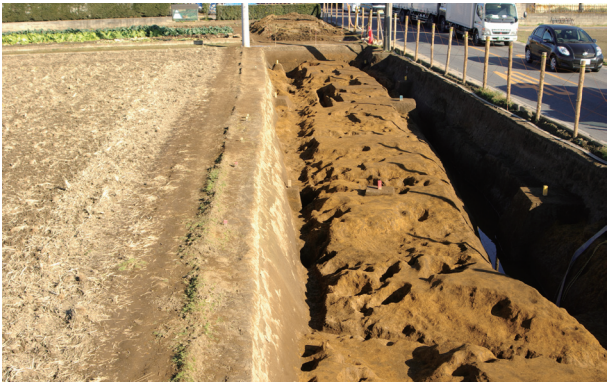
3 ②区第5号溝跡
