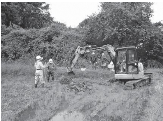
写真3 調査風景(掘削)
