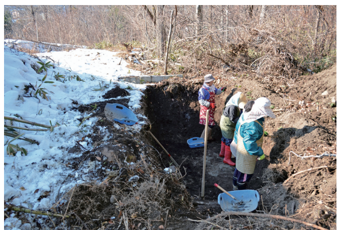
8. 作業風景 (南東から)
