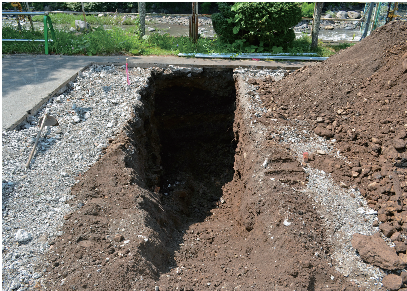
2. 羽根尾字宮原<No.1>（北から）
