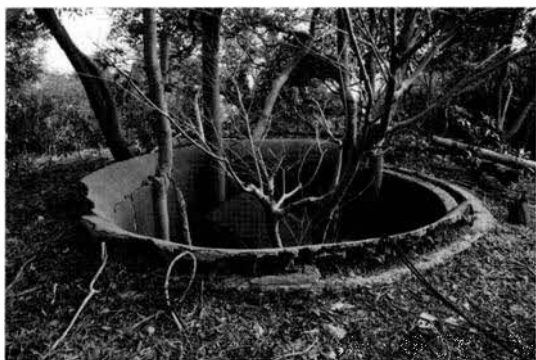
写真7 佐香防空監視哨跡聴音壕(南西から)
