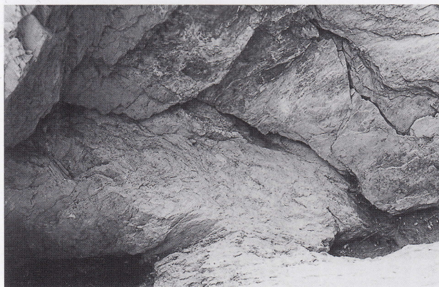
洞穴天井の亀裂（2）
