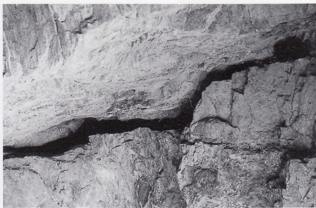
洞穴天井の亀裂（1）
