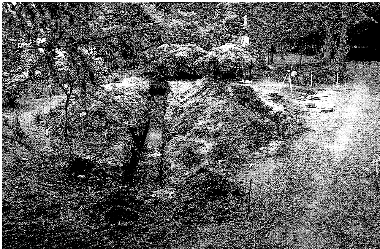
写真6 トレンチ掘削状況（北西側より）
