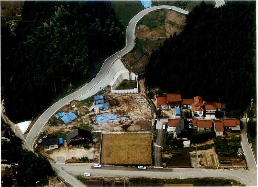
遺跡全景(1989年、南東から)
