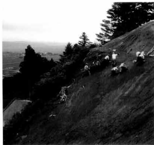
谷部掘削作業
