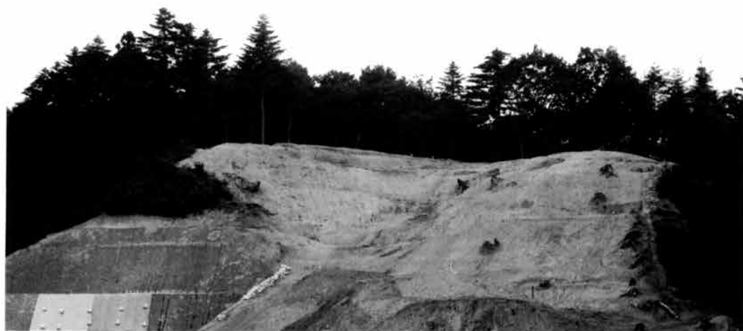
完掘状況（南東から）
