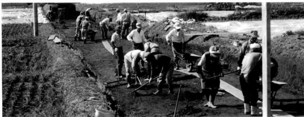
南部掘削作業
