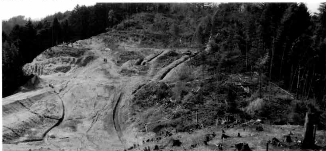
掘削前全景（南東から）
