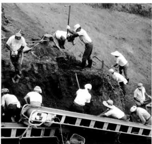
南部掘削作業
