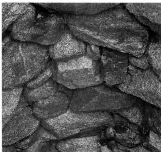
第3号井戸内部
