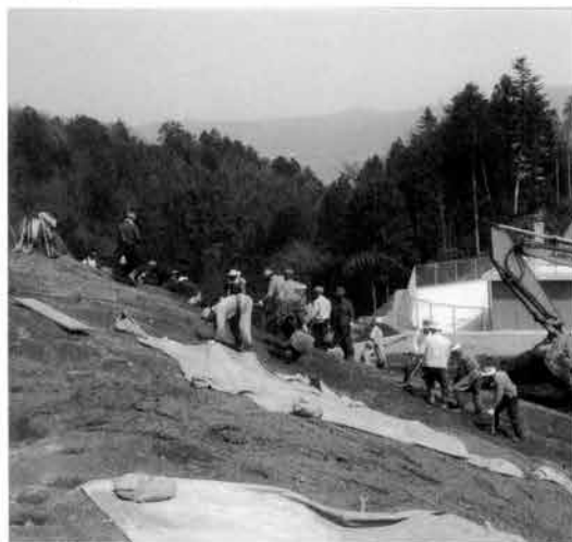
南部掘削作業 (1988年)
