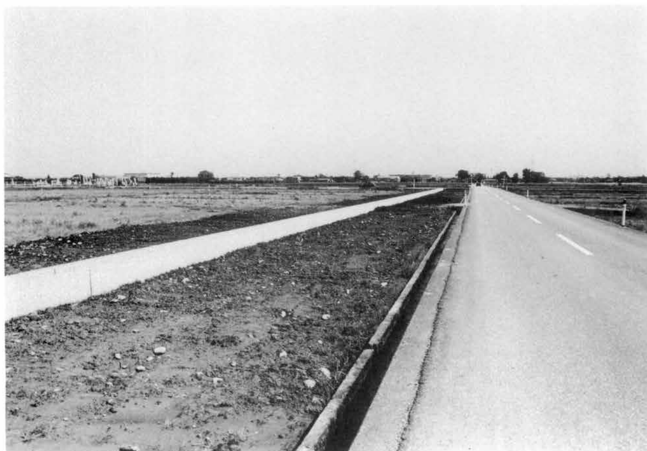
C調査区調査前状況（南東から）
