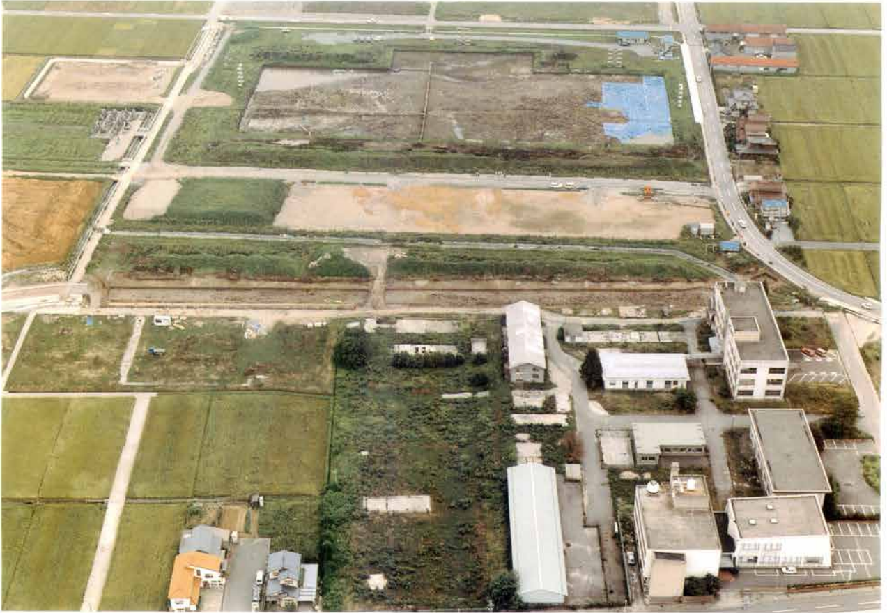
調査区の全景（西から）
