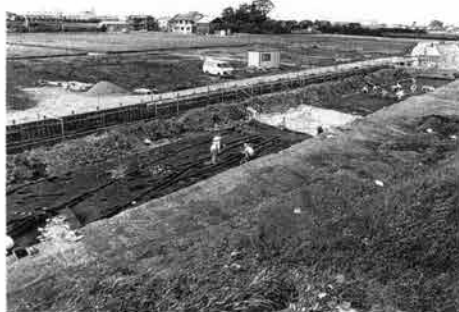
B地区作業風景
