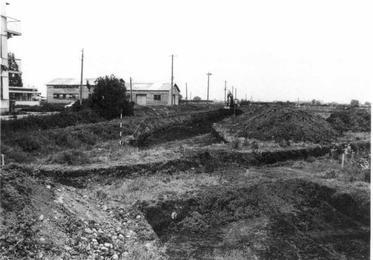
B調査区表土除去作業状況
