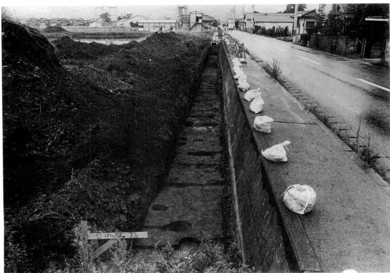
同 上 完掘状況（西から）
