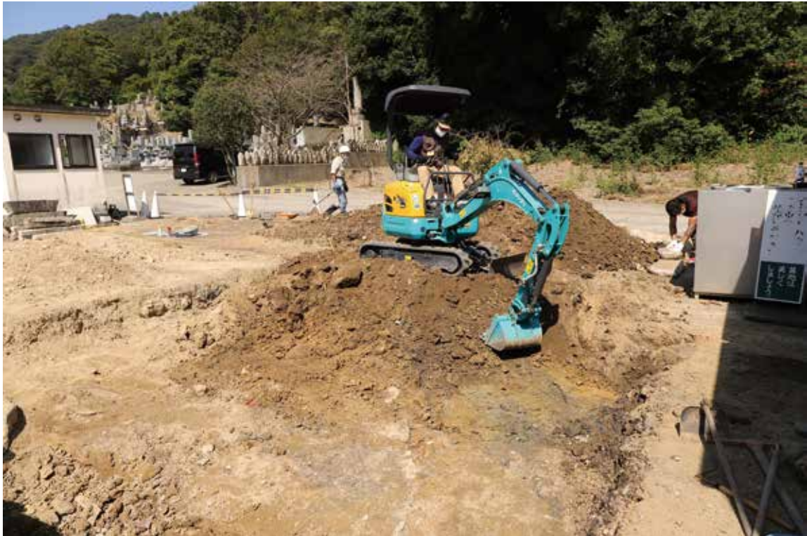
重機掘削作業
