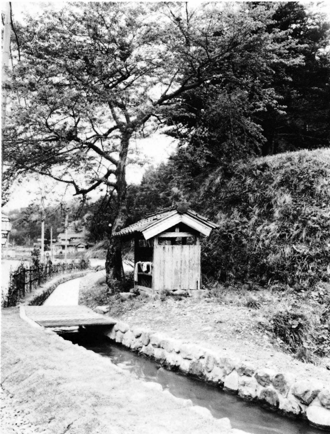
下城戸導水路工 東北から
