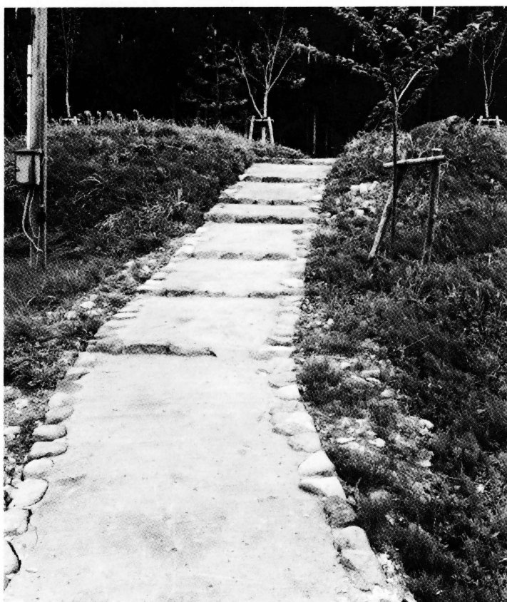
出雲谷園路造成工 西から
