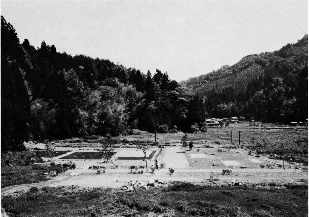
寺院跡整備状況 南から
